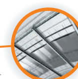
Tinglados ya construidos
